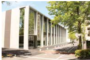
27 フロンティア研究棟
